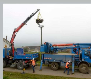
RUE DE L'ÉGLISE 11 H 45 : NOUVEAU PYLÔNE Après un trajet d'une cinquantaine de mètres, le nid de cigogne est installé rue de l'Église. Il est posé dans un support adapté. La nacelle est à nouveau mobilisée pour enlever les tiges de fer et fixer solidement le nid avant les tempêtes d'hiver.
