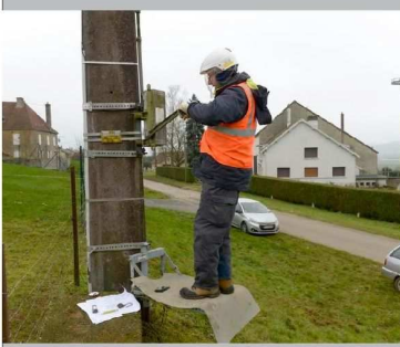
MAIRY, JEUDI 7 DÉCEMBRE 9 H 30 : COUPURE DU COURANT Avant toute autre chose, les techniciens d'Enedis procèdent à la mise hors tension des lignes concernées par l'opération. Cette interruption est suivie de plusieurs procédures de vérification de la mise en sécurité du pylône de la rue de la Creuse-Ville. La population avait été avertie de la coupure par courrier.
