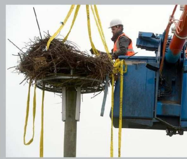
RUE DE LA CREUSE VILLE, 10 H 30 : SANGPAGE La stratégie, après concertation avec les spécialistes, est retenue. Deux tiges en fer sont enclâssées dans la structure du nid. Des sangles sont mises en place et bloquées sur les tiges. L'opération est minutieuse car il ne faut pas forcer sur la structure du nid.
